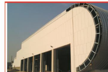
Tường bên ngoài nhà máy bột giấy Phenix
